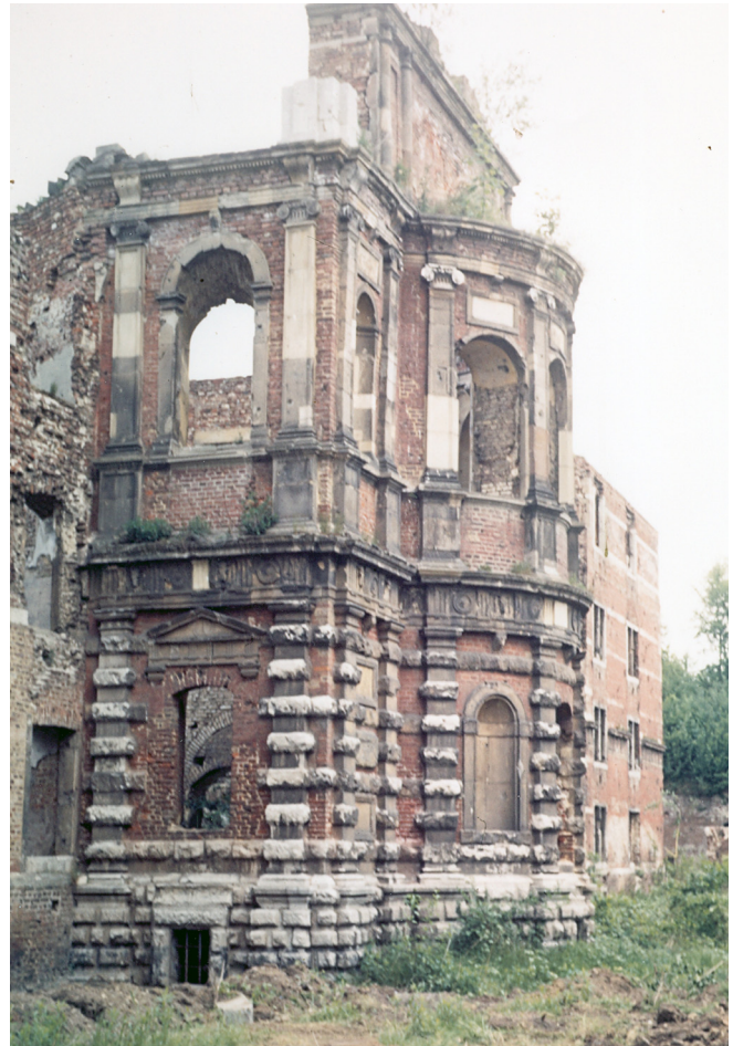
Bild 7 (li.): Westfassade der Kapelle im Zustand nach dem Kriege. In den Wänden sind die Balkenlöcher für die Zwischendecken sichtbar. Entnommen: Neumann, Zitadellenführer, S. 135
