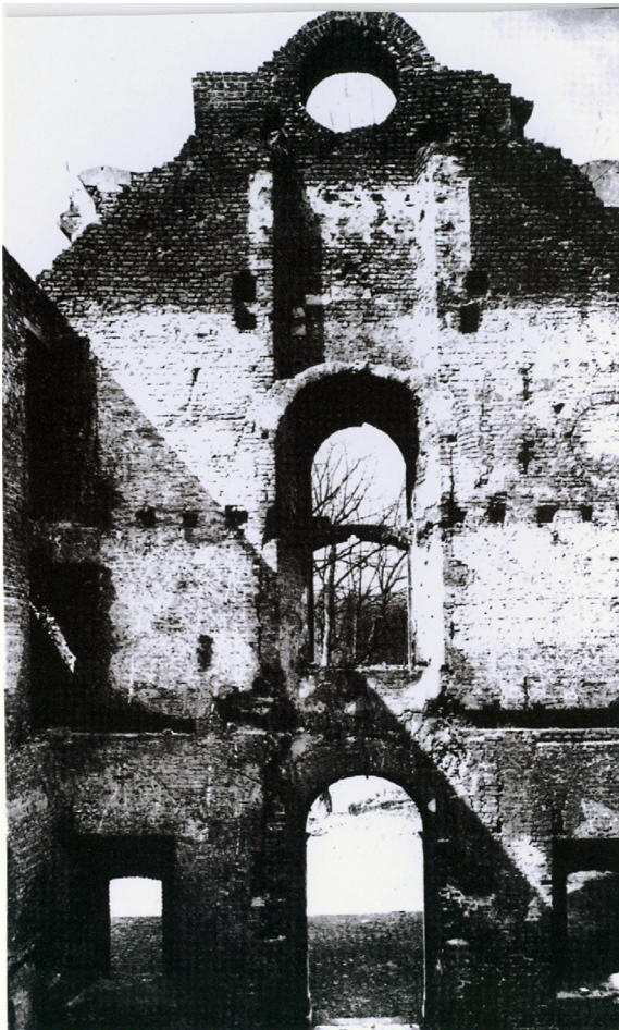
Bild 7 (li.): Westfassade der Kapelle im Zustand nach dem Kriege. In den Wänden sind die Balkenlöcher für die Zwischendecken sichtbar. Entnommen: Neumann, Zitadellenführer, S. 135
